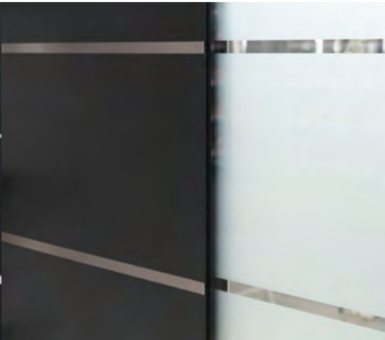
Alunox 10mm Flächenbündig eingelassen
